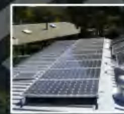
太阳能光伏屋顶 SOLAR PHOTOVOLTAIC ROOF 节能减排/创造价值
